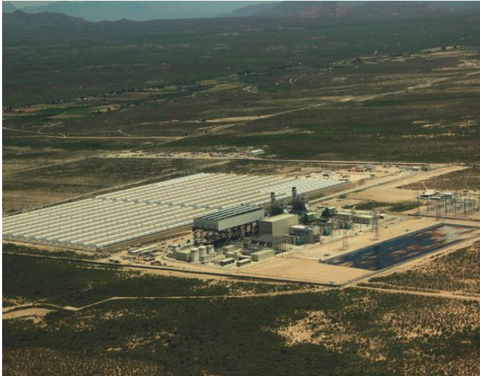
Central de Ciclo Combinado con Campo Solar Agua Prieta II. (fuente: SENER 2013 ).
